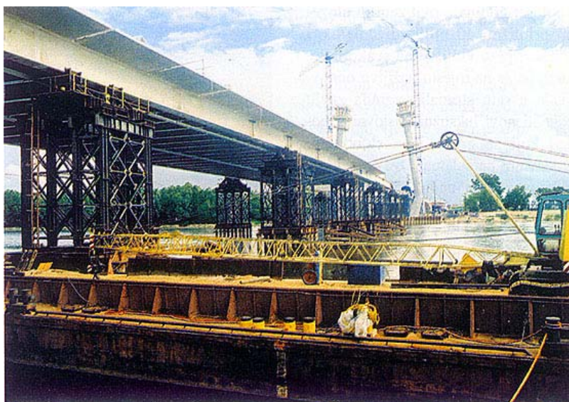
Pogled na gradalište mosta
