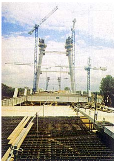
Gradnja pilona i ugradnja čeličnih nosača
