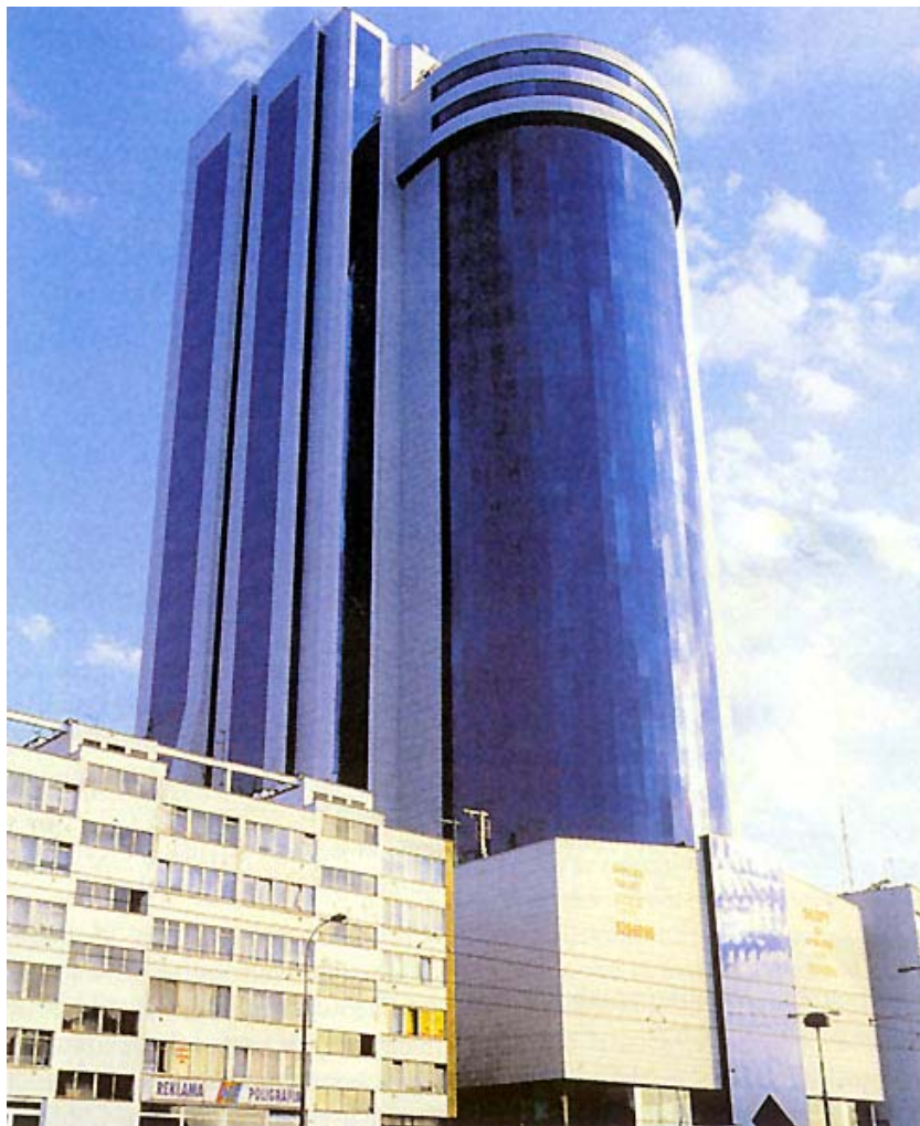
Novi poslovni toranj Reform plaza
