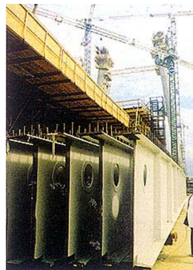
Nosači pripremljeni za ugradnju
